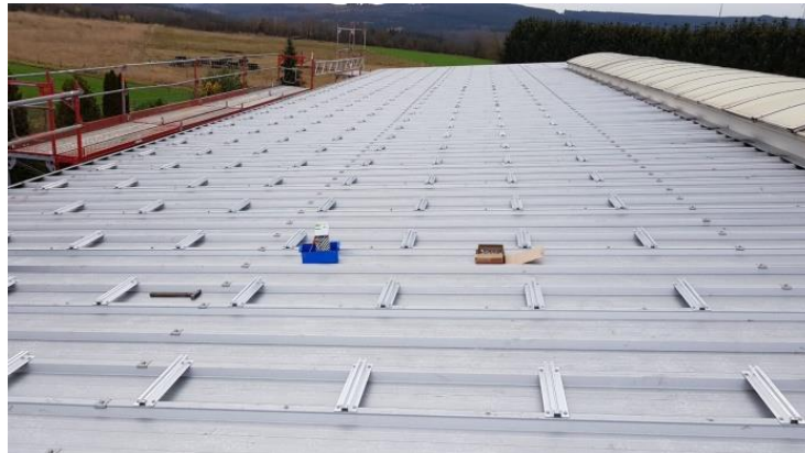
Unterkonstruktion auf 1. Hallendach
